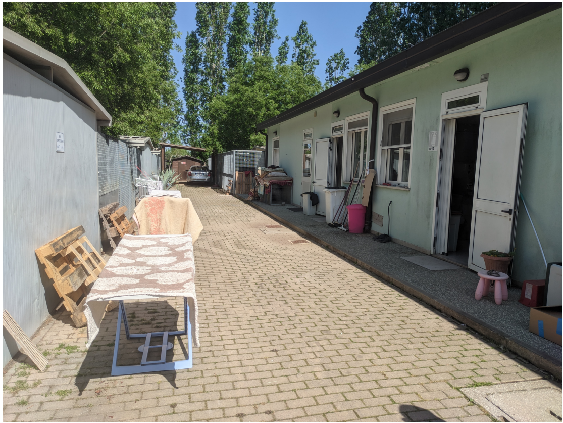
Figura 9: Area esterna palazzina servizi
